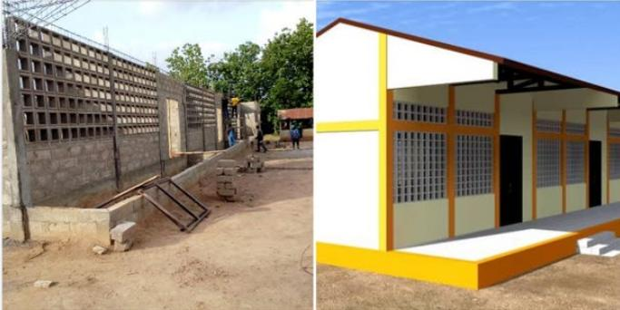
Les murs en élévation sont terminés. Quelques chaînages verticaux sont encore à bétonner. Les chaînages horizontaux vont être réalisés cette semaine.
